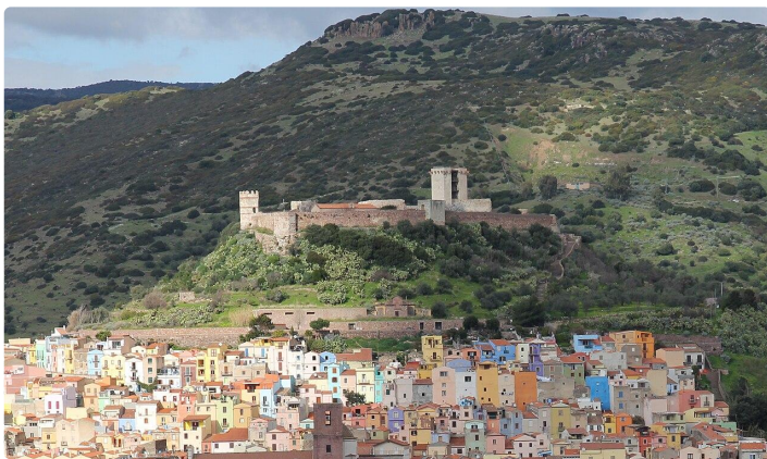
Zamek Serravalle nad dzielnicą Sa Costa; w kaplicy na zamku zachowały się XIV-wieczne freski. Fot. Gianni Careddu, CC BY-SA 3.0 , Wikimedia Commons
